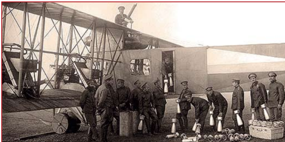
1915 г. (июль). Влодава. Корабль «Илья Муромец III» поручика Озерского. Погрузка 35-фунт. Бомб и двух ящиков стрел, на верхнем крыле пулемет «Максим».
